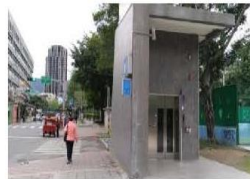
4 大豐公園地下停車電梯出入口
