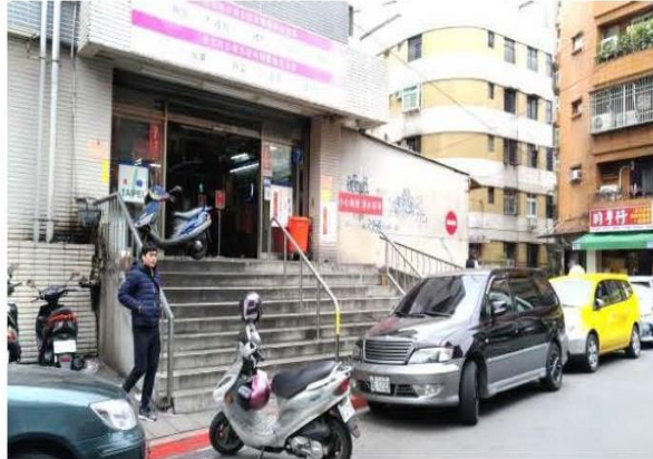
8 新市街 24 巷內市場出入口高低差
