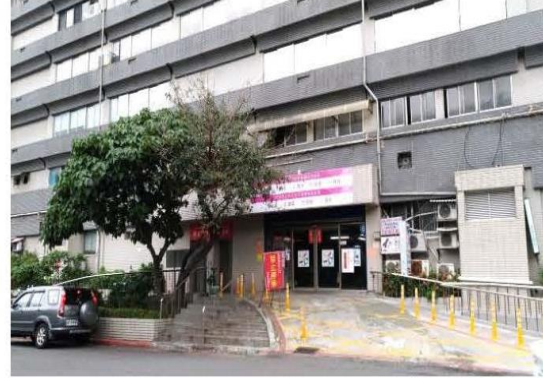
9 磺港路市場出入口高低差
