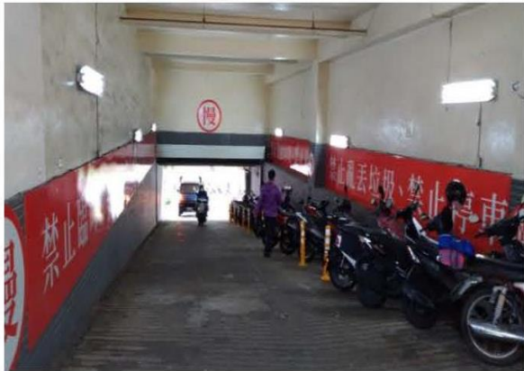
7 市場內二樓車道及卸貨空間
